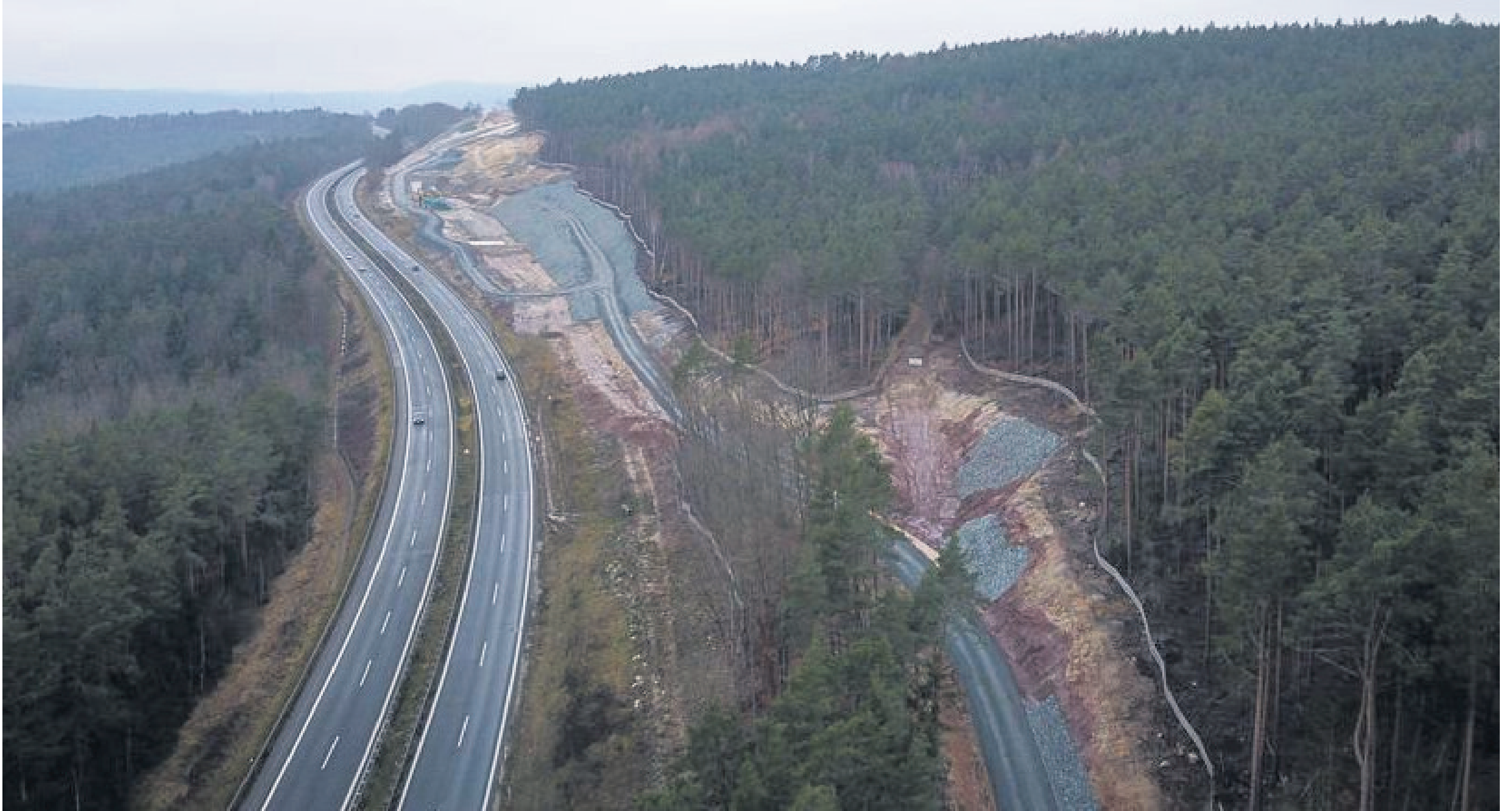
Von oben sieht man die gewaltigen Erdarbeiten für die Trasse der A 70 bei Thurnau.
